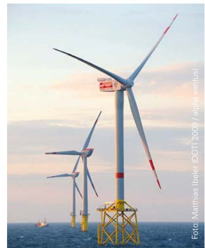
Offshore-Windpark alpha ventus: Errichtung REpower M1 068
