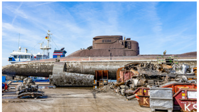
Der größte Bagger der KSH wiegt etwa 140 Tonnen (oben). Die Zerlegung dreier ausgerangierter U-Boote stellte eine besondere Herausforderung dar (unten).
